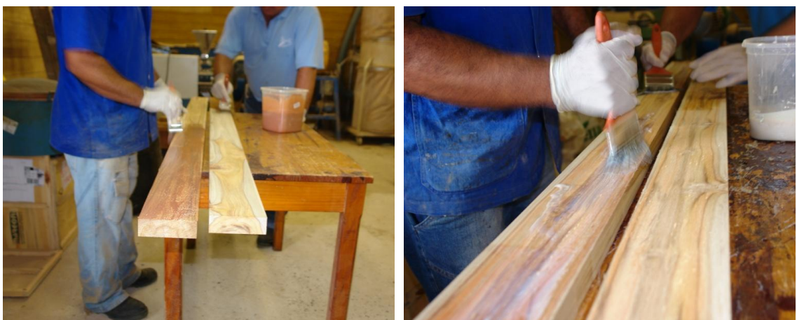
Figura 14 - Aplicação do adesivo nas lamelas e montagem das cruzetas
